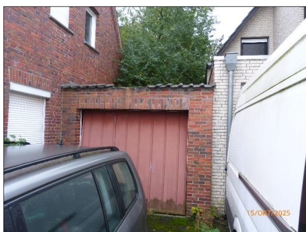
nordwestliche Ansicht - Garage
