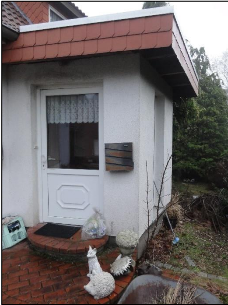
westliche Gebäudeansicht (Eingangsbereich)
