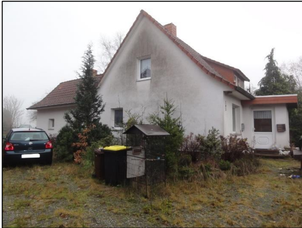
westliche Gebäudeansicht mit Verfärbungen
