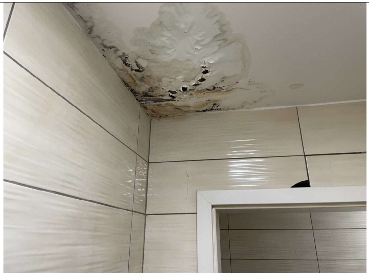
Schimmelbefall / Feuchtigkeitsschäden
