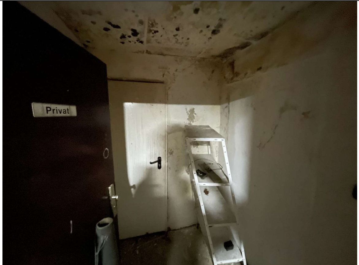
Schimmelbefall / Feuchtigkeitsschäden
