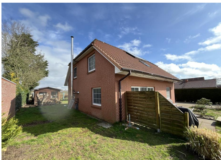
Bild 3: Giebelansicht des Bewertungsobjekts
