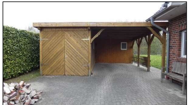
Carport mit Geräteraum
