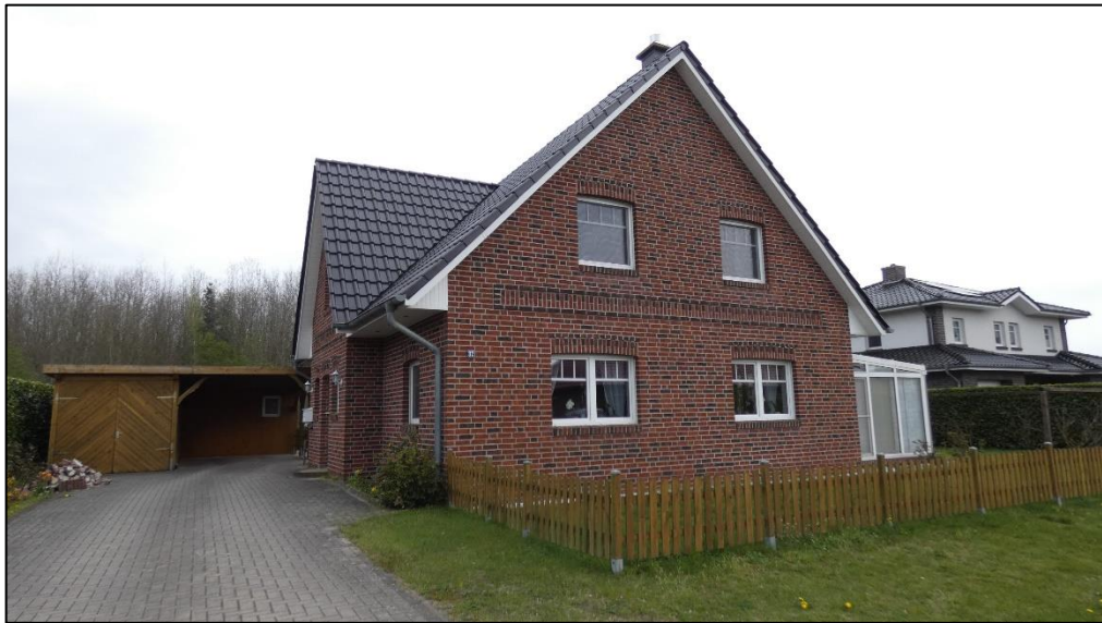
Objekt: Barßel, Karl-Zessin-Straße 32
