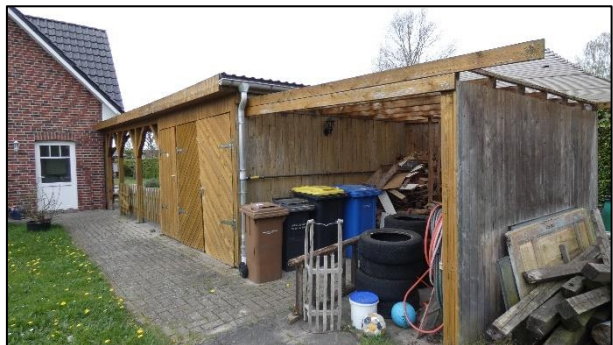
Carport und Schuppen
