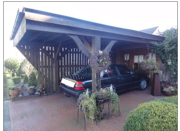
Carport südliche Ansicht
