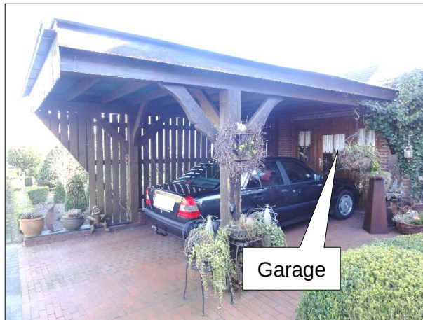
südwestliche Ansicht Garage mit vorgebautem Carport
