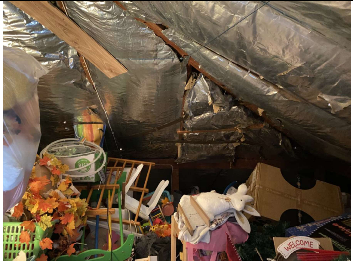
Dachgeschoss nicht ausgebauter Teil
