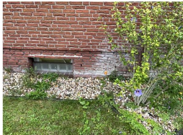
Bild 6: Schäden an der Verblendung
