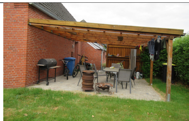
Terrasse mit Überdachung
