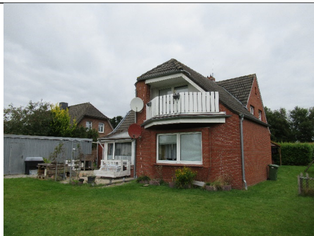
Ansicht vom Garten (Anbau)
