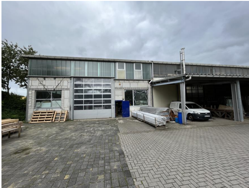
Bild 3: Seitenansicht der hinteren Halle mit Schleppdach
