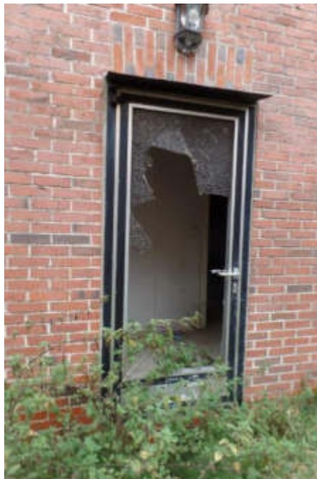
Hintereingang Wohnhaus, Außenansicht
