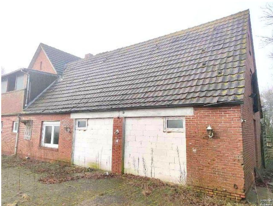
Nordostansicht auf Anbau an Rückseite Wohnhaus
