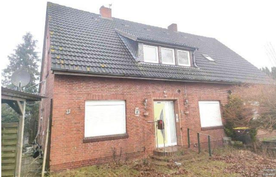
Südansicht auf Wohnhaus mit Haupteingang
