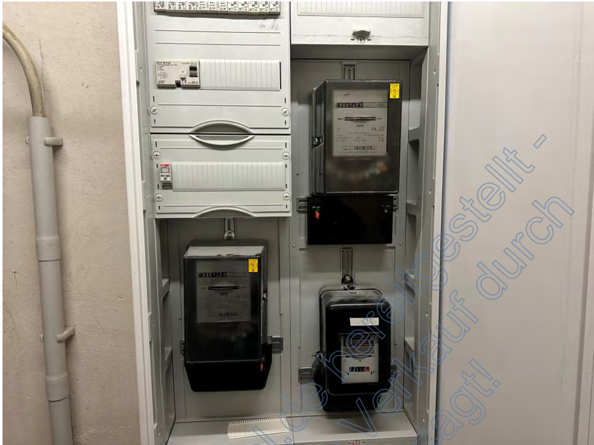
Bild 39: Ausschnitt – Zählerschrank im Hausanschlussraum (Einfamilienhaus KG).
