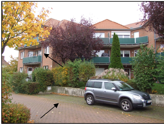
Geb. Westseite / Pkw-Außenstellplatz
