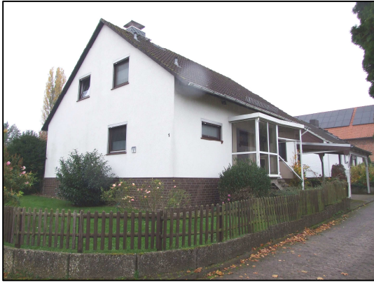
Gebäude Nord- und Ostseite
