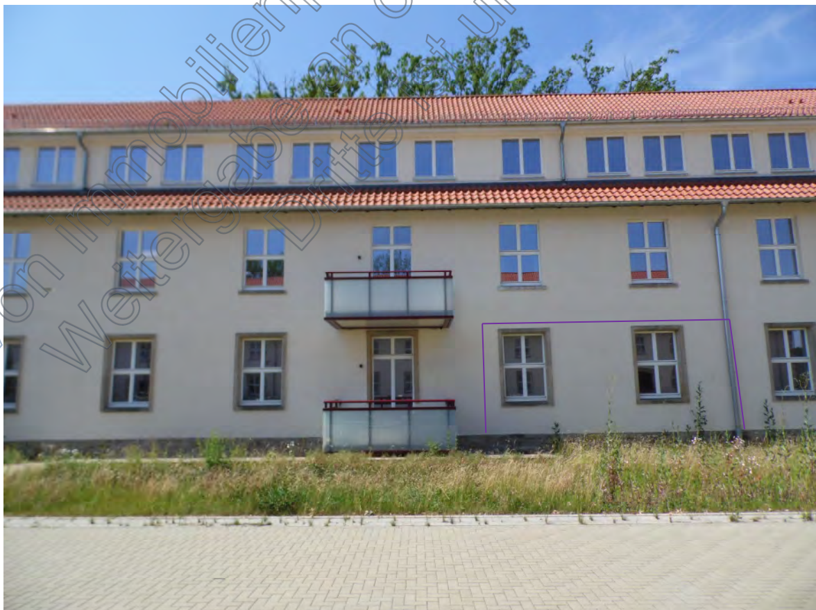
Bild 04: Blick auf den mittleren Teilbereich der östlichen Traufseite ( Hofseite ) des Westtraktes . Im
