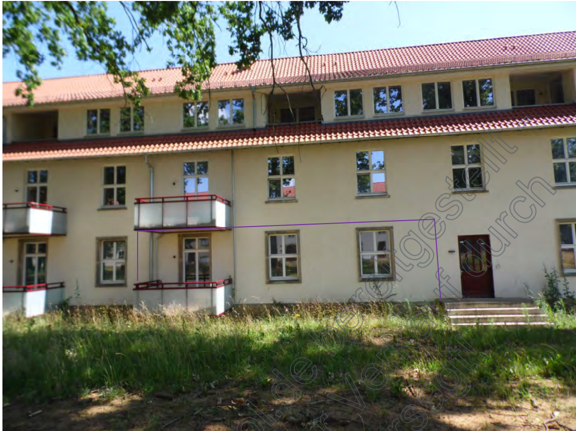
Bild 05: Blick auf den mittleren Teilbereich der westlichen Traufseite des Westtraktes . Im Erdgeschoss sind von links der Wohnzimmerbalkon und die beiden Schlafzimmerfenster der Wohnung Nr. 4 zu sehen.
