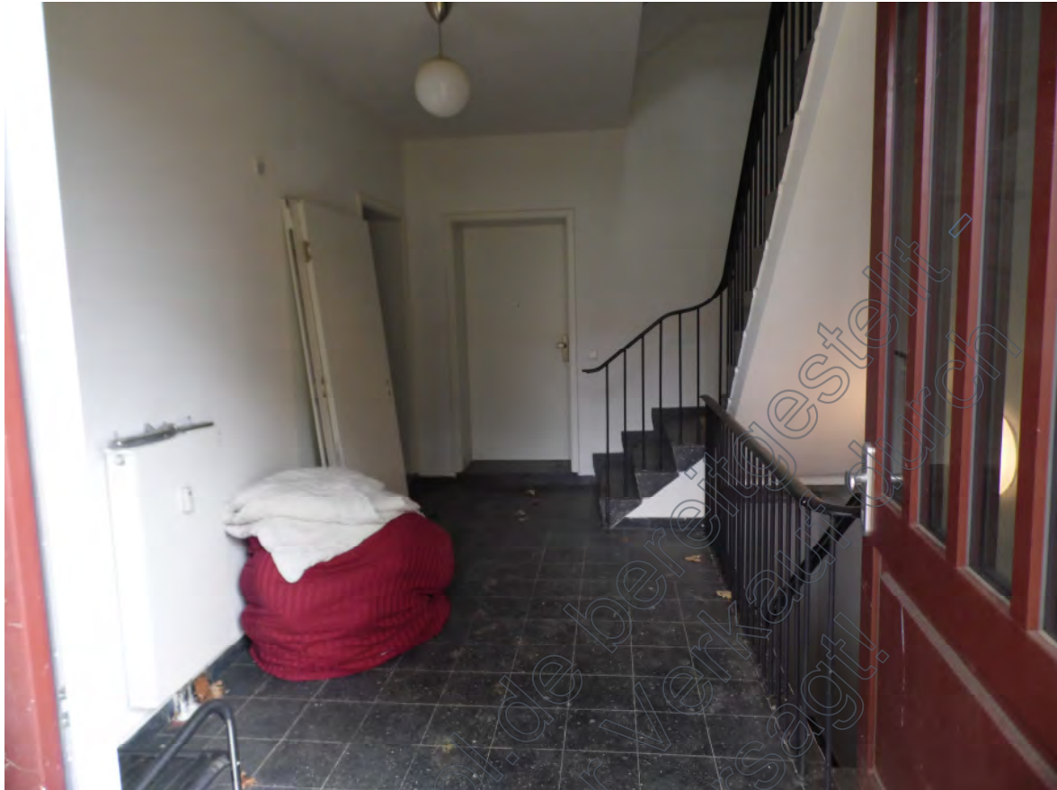
Bild 07: Ausschnitt – mittleres Treppenhaus 1 Richtung Wohnungseingangstüren zur WHG 4 und WHG 5 ( Westtrakt Wohnanlage Nelkenhof EG ).
