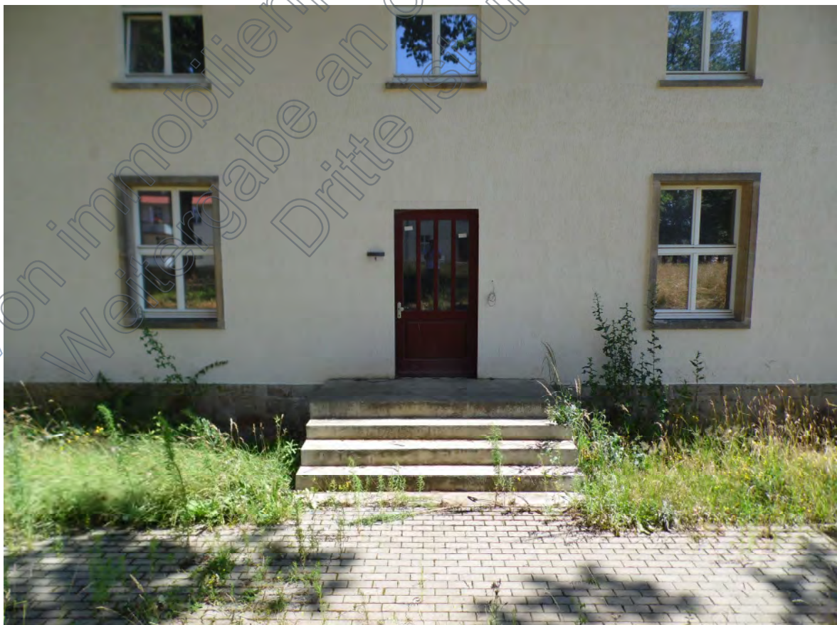
Bild 06: Blick über die Eingaanstiege auf die geschlossene Hauseingangstür zum mittleren Treppenhaus 1
