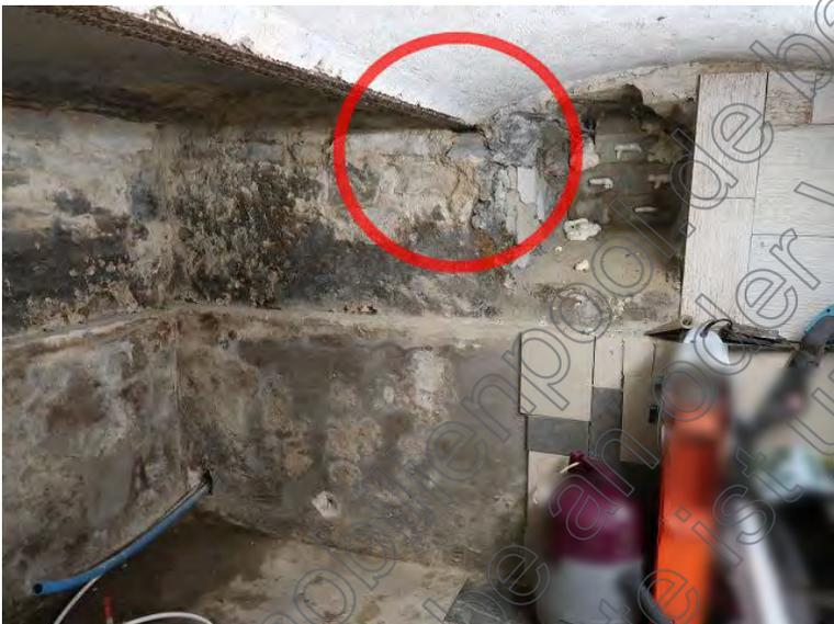
Rost-/Schäden Stahlträger Decke KG beispielhaft
