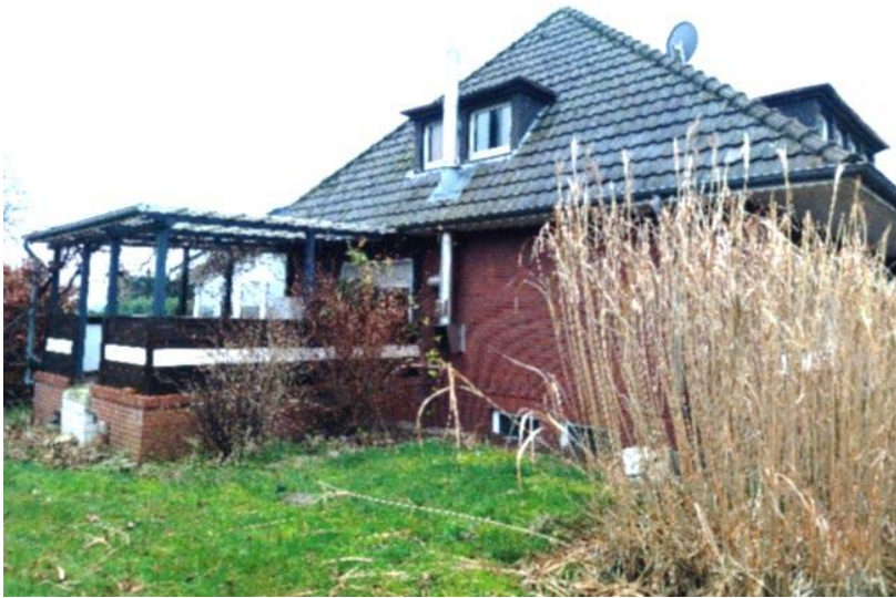
Westansicht auf Nordseite Wohnhaus mit überdachter Terrasse
