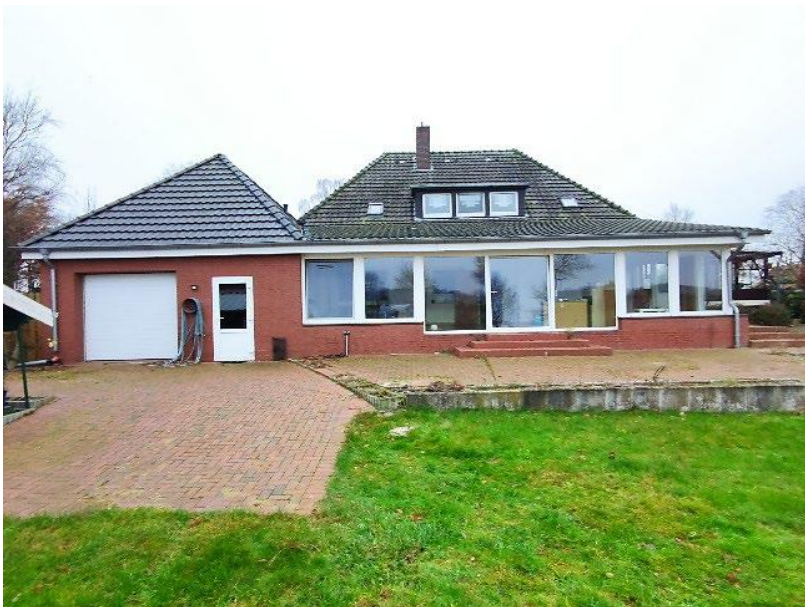
Nordostansicht auf Rückseite Wohnhaus mit Garage und Wintergarten
