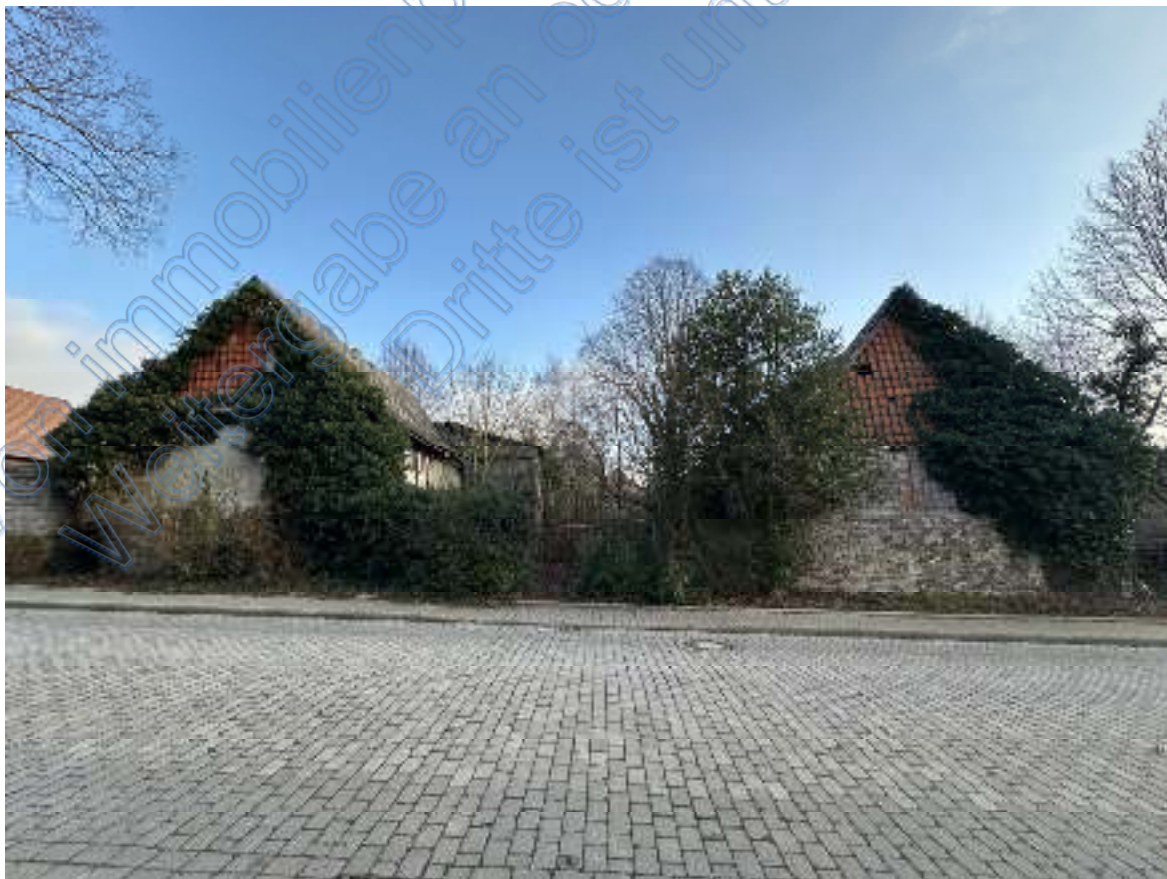
Bild 04: Blick über die Ringstraße auf das Bewertungsobjekt. Rechts ist das Lagergebäude, links ist das Wohnhaus zu sehen.
