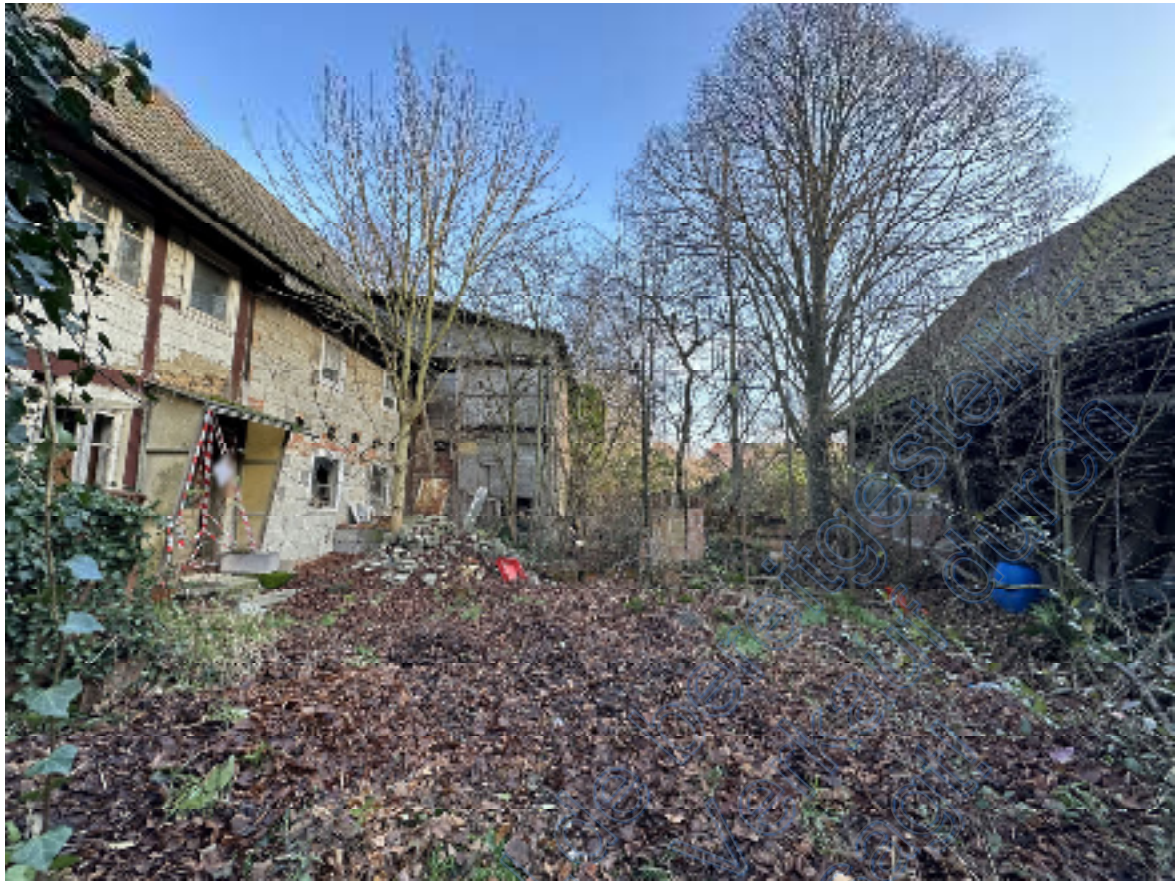
Bild 07: Blick auf und über die „Hofffläche“ des Bewertungsfurstücks 80 in Richtung Osten. Links sind das Wohnhaus und der sich anschließende Lagerschuppen, rechts ist das Lagergebäude zu sehen.
