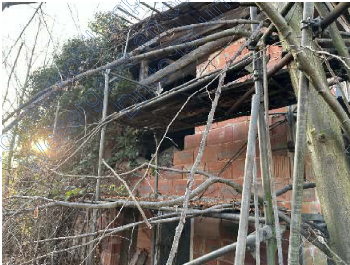
Bild 10: Blick auf die Ostseite des Lagerschuppens.
