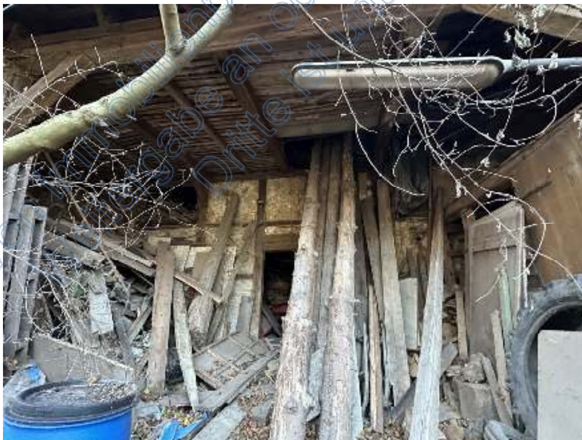
Bild 14: Blick in den mittleren „ offenen “ Teilbereich des Lagergebäudes.
