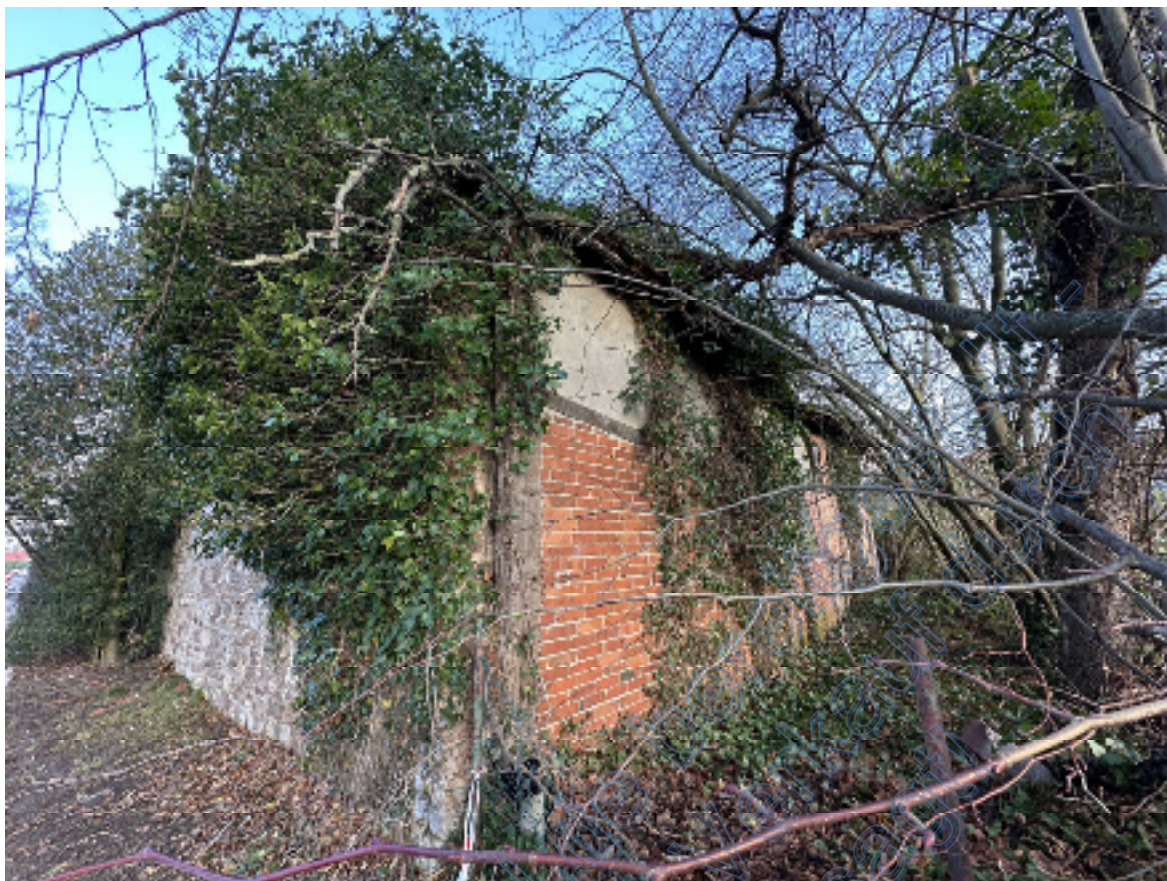
Bild 03: Blick auf und entlang der südlichen Traufseite des Lagergebäudes in Richtung Osten.
