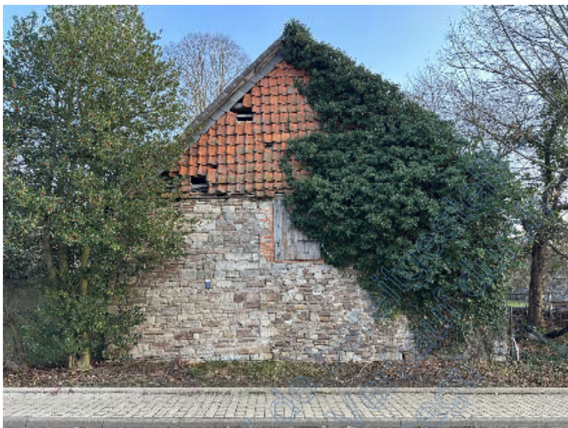
Bild 05: Blick auf die westliche Giebelseite des Lagergebäudes.
