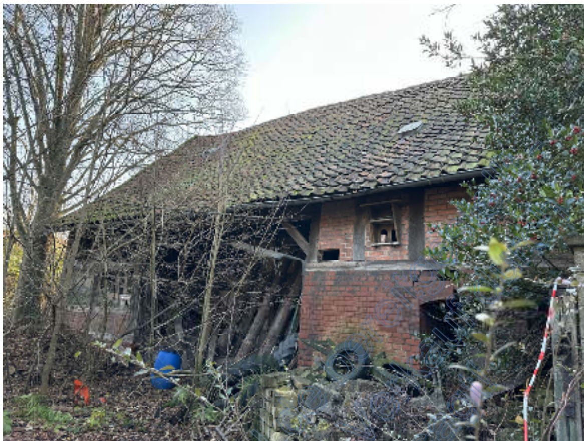
Bild 13: Blick auf die hofseitige nördliche Traufseite des Lagergebäudes.
