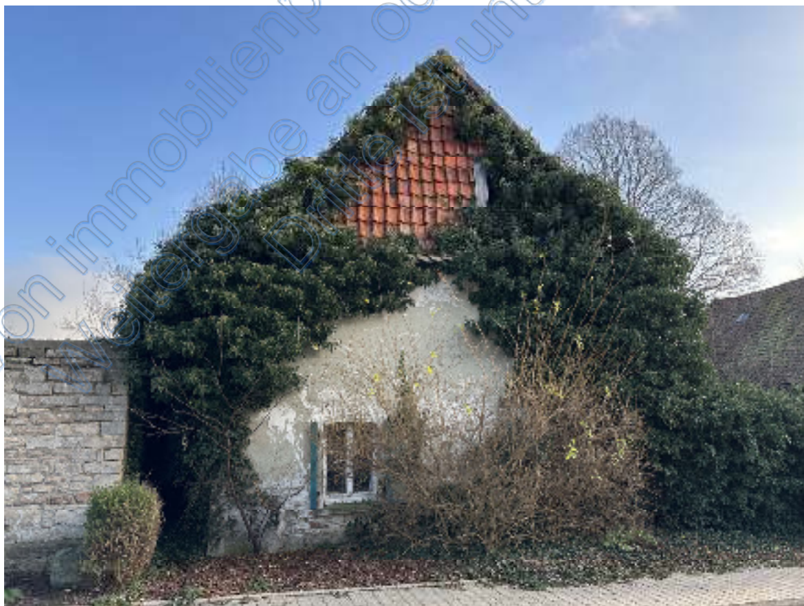
Bild 06: Blick auf die westliche Giebelseite des Wohnhauses.
