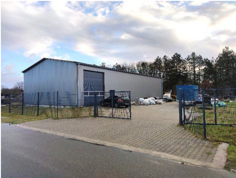
Südwestansicht auf grundstückszufahrt und Vorderseite Lager und Maschinenhalle
