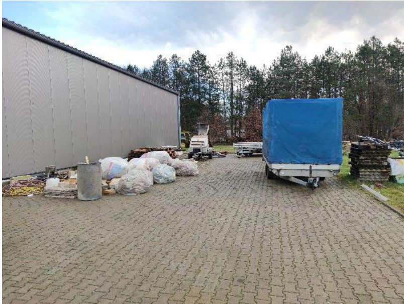
Gepflasteter Außenbereich entlang der Südseite der Lager- und Maschinenhalle
