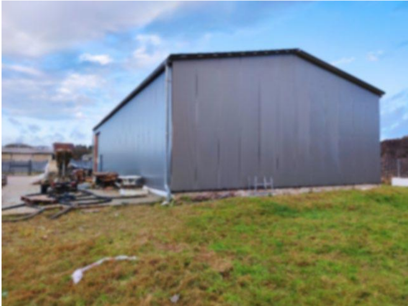
Südostansicht auf Lager- und Maschinenhalle mit Verkleidung aus Sandwichpaneelementen
