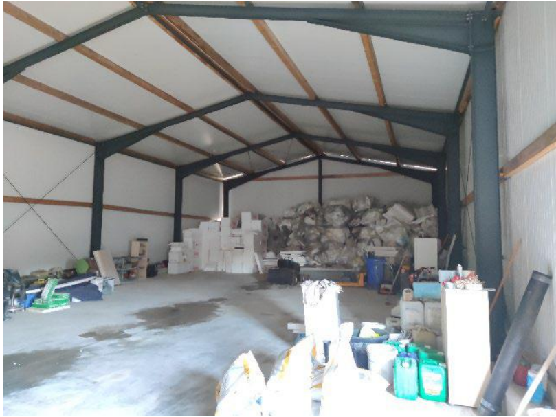
Innenansicht Lager- und Maschinenhalle mit Betonboden
