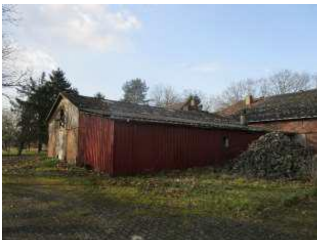
Ansicht von Norden -Anbau Wirtschaftsteil
