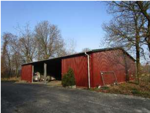
Gerätehalle: Ansicht von Südosten
