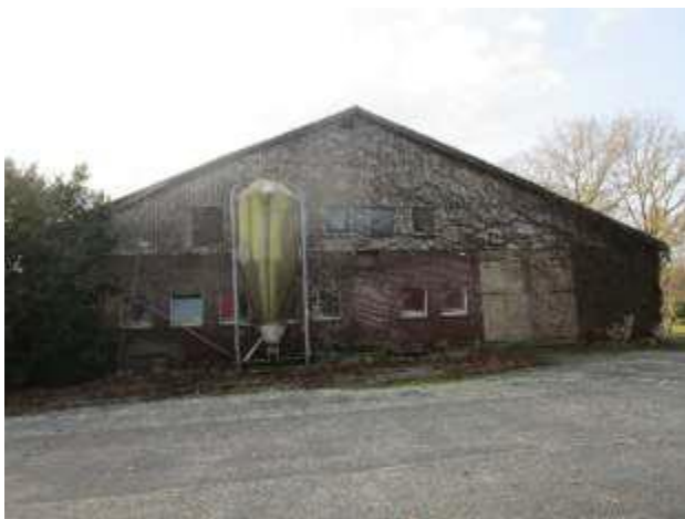
Ansicht von Norden – Wirtschaftsteil
