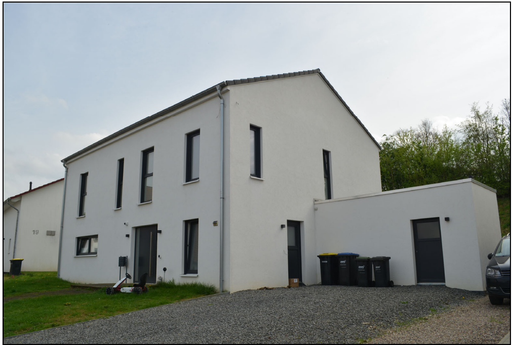
Bild 1 oben: Straßenfront- und Eingangsseite
