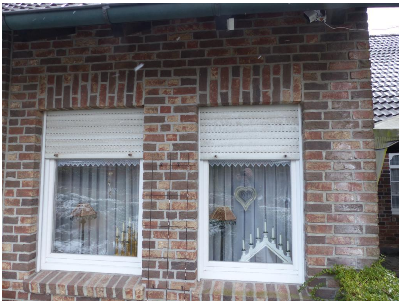
Abriss der Rollschicht über dem Fenster des Abstellraums
