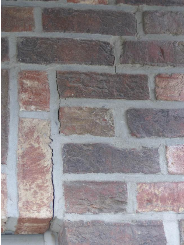
Abriss der Rollschicht über dem Fenster des Abstellraums
