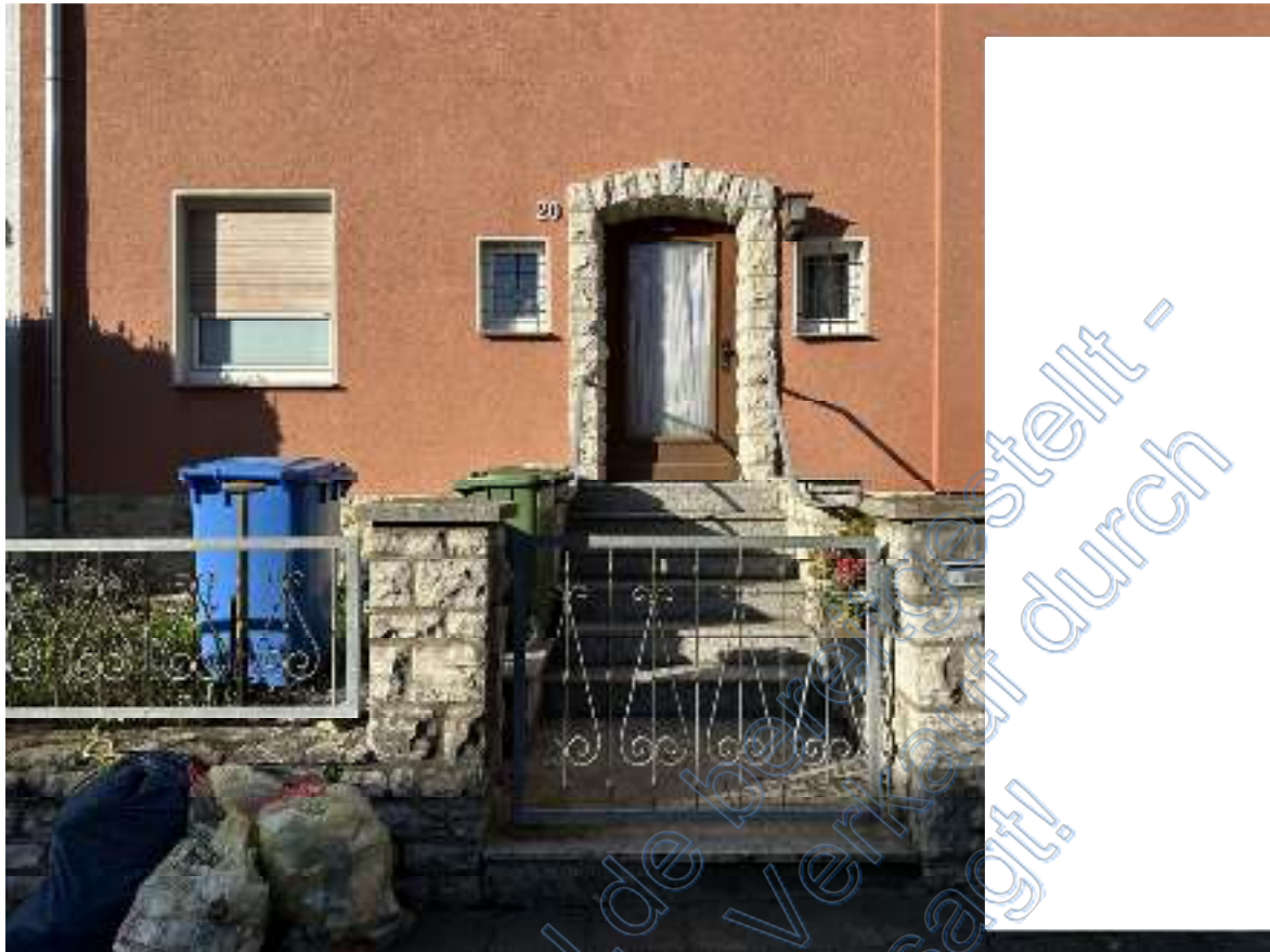
Bild 03: Blick über die Zugangspforte und die Eingangstreppe auf die geschlossene Hauseingangstür zum Eingangsflur des Reihenmittelhauses .
