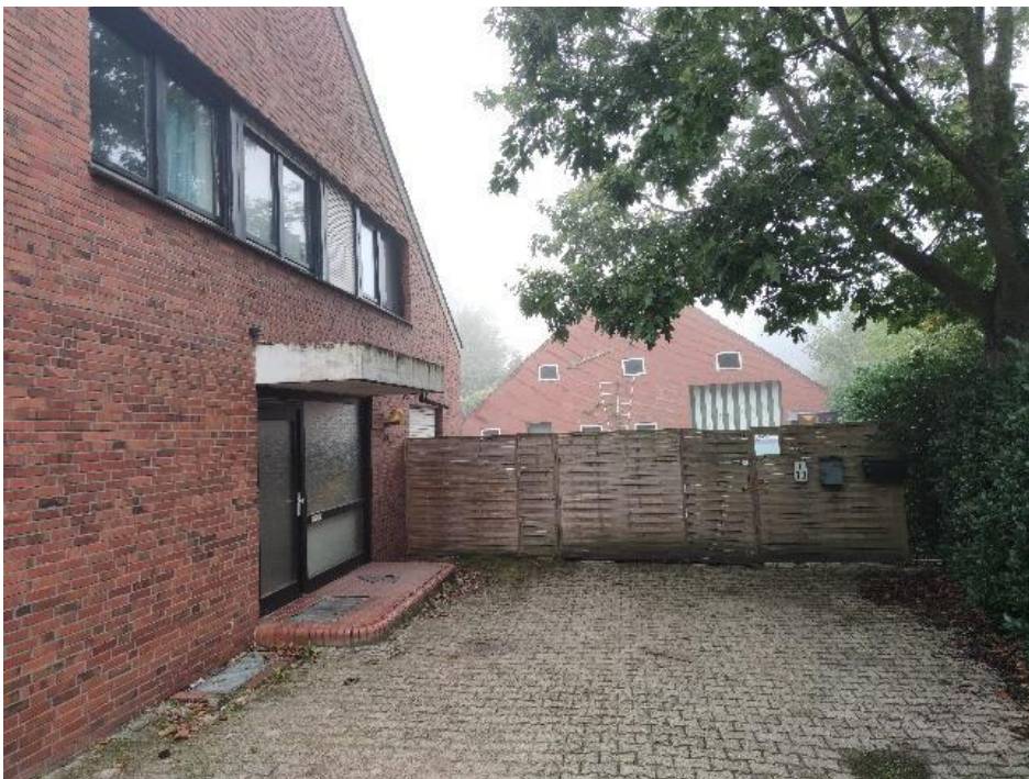
Ostgiebel Wohnhaus mit Haupteingang
