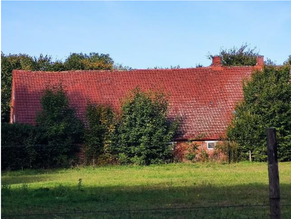
Ostansicht auf Wohn-/Wirtschaftsgebäude „Herzogstraße 73“
