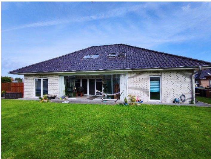
Nordostansicht auf Rückseite Wohnhaus
