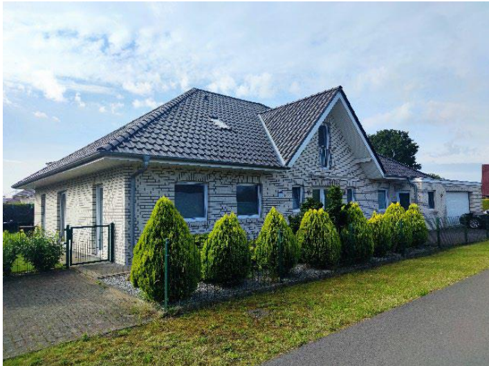
Nordansicht auf Wohnhaus mit Garage
