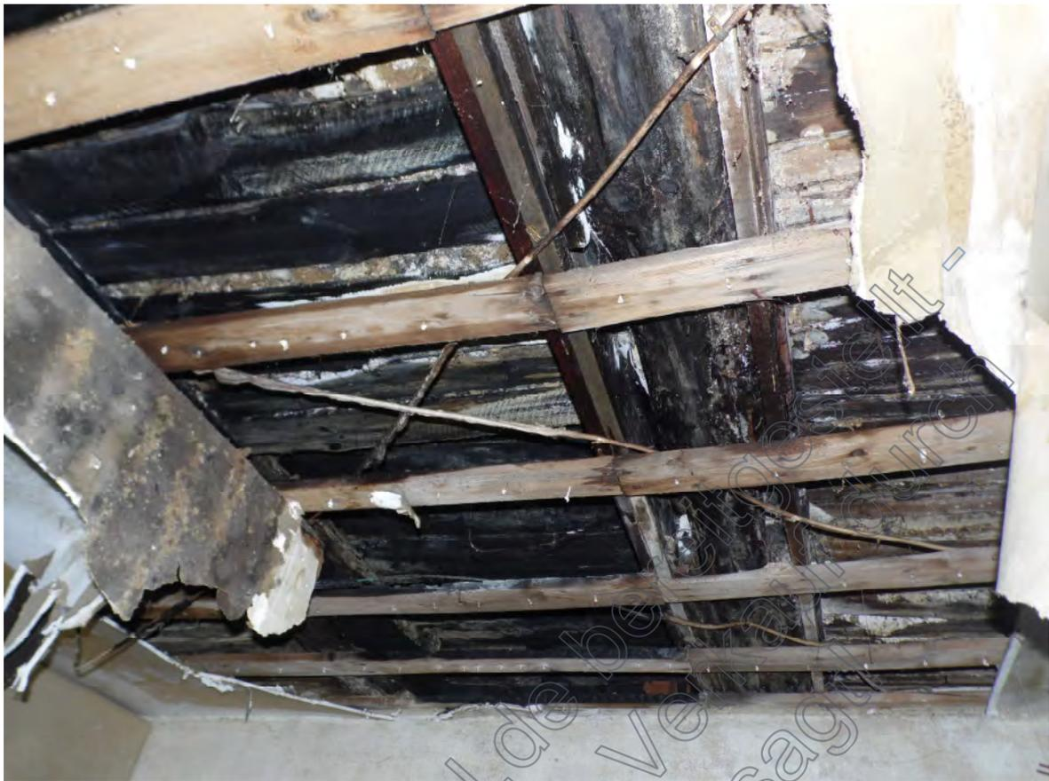
Bild 07: Ausschnitt – durch Brand und Löschwasser geschädigter Deckenbereich des Ladengeschäftes
