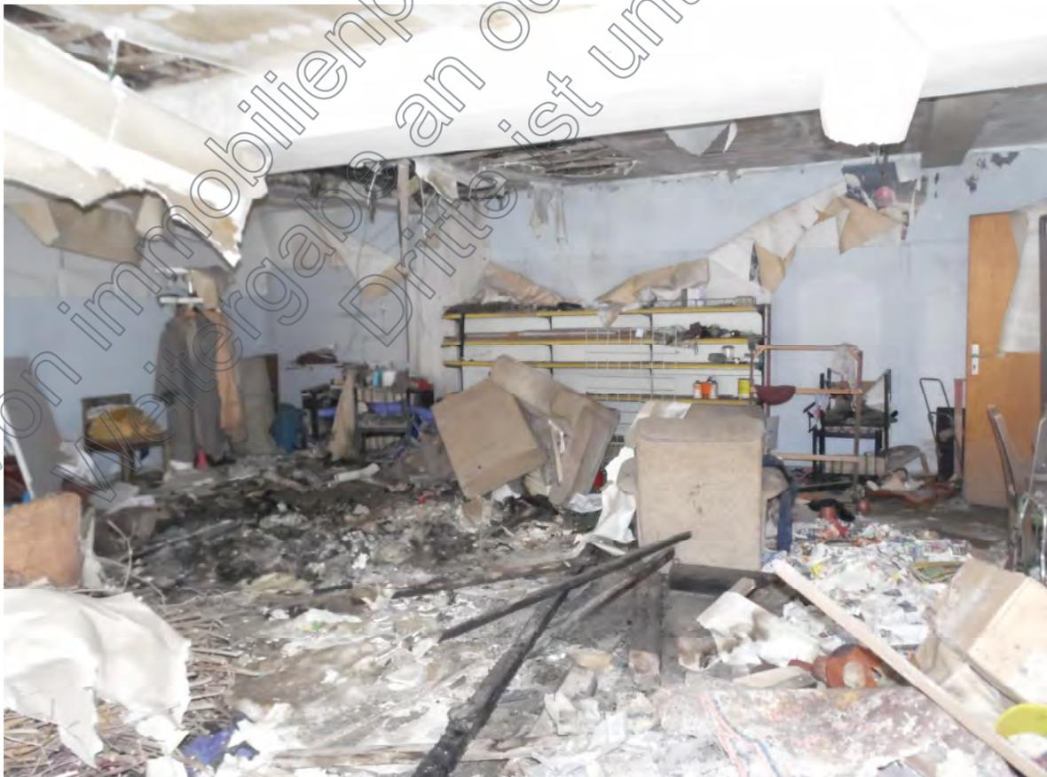
Bild 06: Ausschnitt – durch Löschwasser geschädigtes Ladengeschäft mit offenen / „zerstörten“ Deckenbereich (brandgeschädigtes **Wohn- und Geschäftshaus Gewebereinheit EG**).
