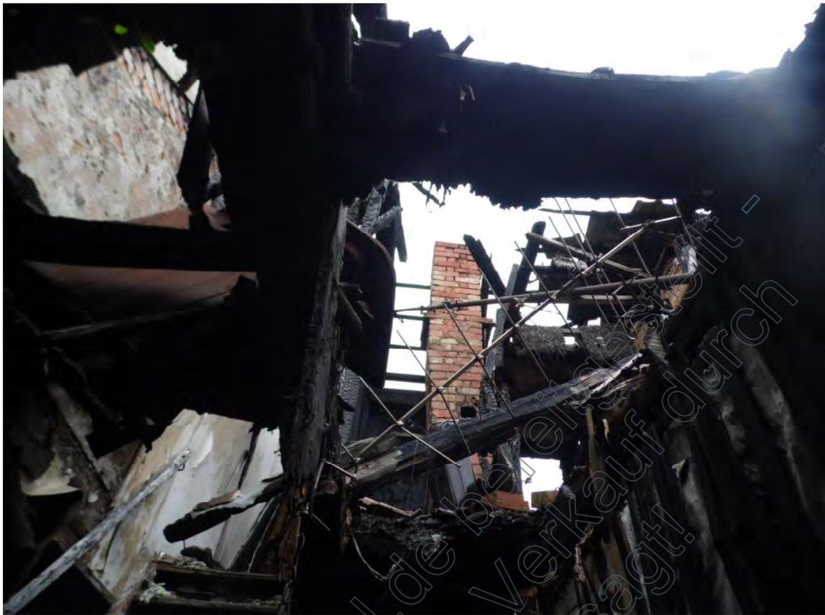
Bild 13: Ausschnitt – völlig zerstörtes Dachgeschoss
