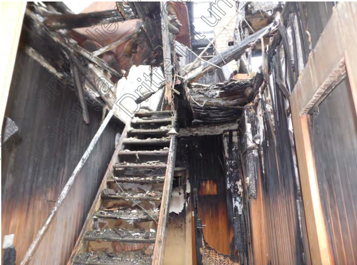
Bild 12: Ausschnitt – stark brandgeschädigter Flur mit Blick in das völlig zerstörte Dachgeschoss (brandgeschädigtes **Wohn- und Geschäftshaus Wohneinheit OG**).
