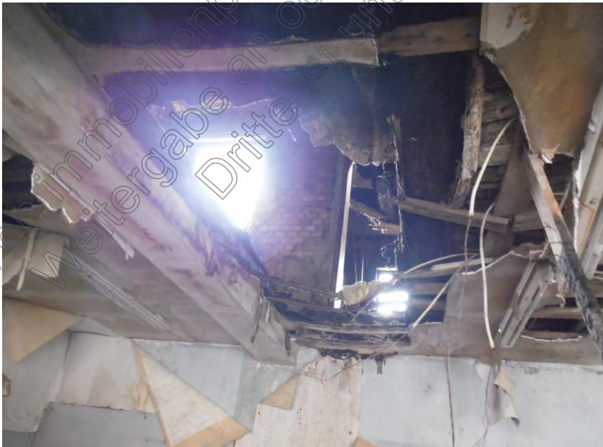
Bild 08: Ausschnitt – durch Brand und Löschwasser zerstörter, „offener“ Deckenbereich des Ladengeschäftes
