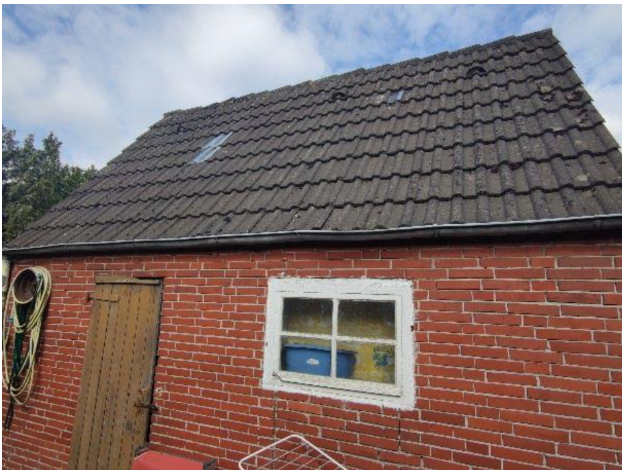
Nahansicht auf Geräteschuppen als Anbau an Garage
