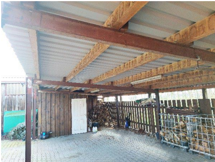
Innenansicht Carport als Stahlkonstruktion
