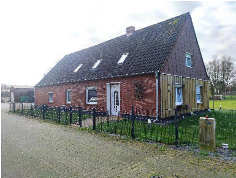
Westgiebel Wohngebäude mit Verkleidungen aus Holz Im eG und Schieferplatten im DG
