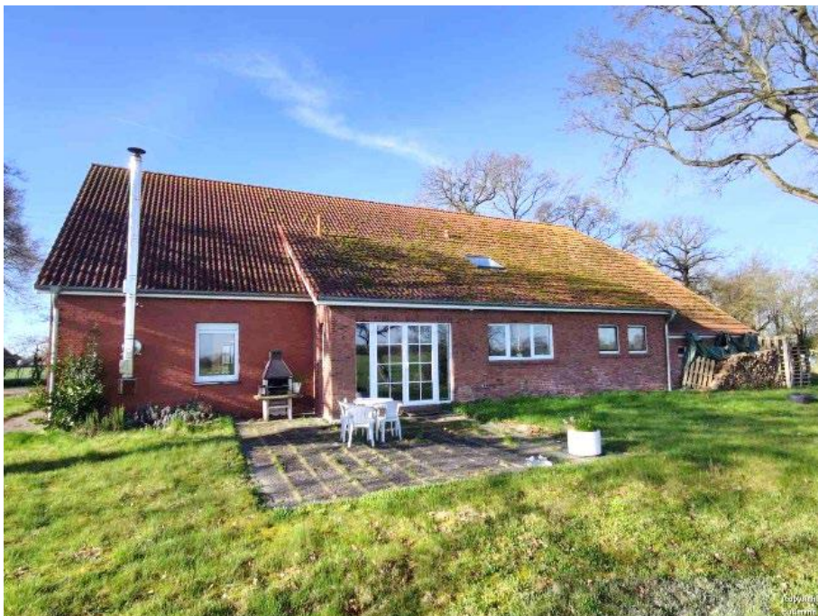
Nordansicht auf Rückseite Wohn-/Wirtschaftsgebäude Mit nicht überdachter Terrasse
