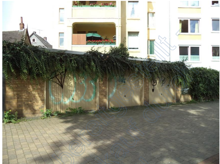
Straßenansicht Garagen von Südosten (Pulverturmwall)
