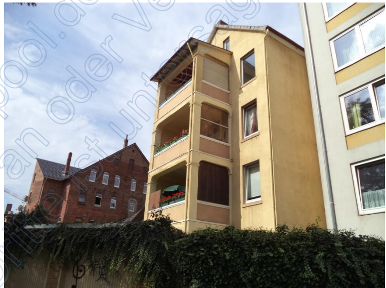
Rückansicht von Nordosten (Pulverturmwall)
