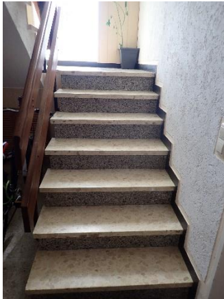
Treppe UG/EG (Altbau)
