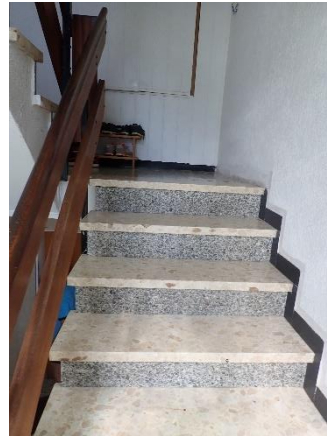
Treppe EG/DG (Altbau)
