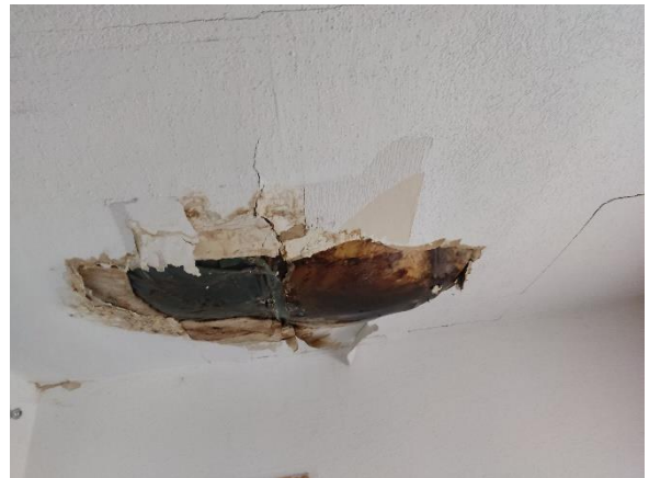
Feuchtigkeitsschaden Diele im EG (Anbau)
