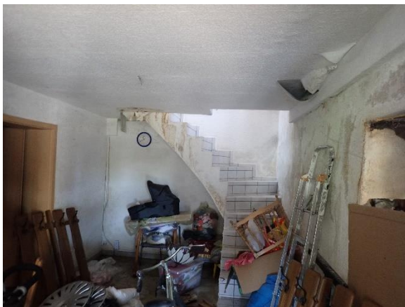
Treppe UG/EG (Anbau)
