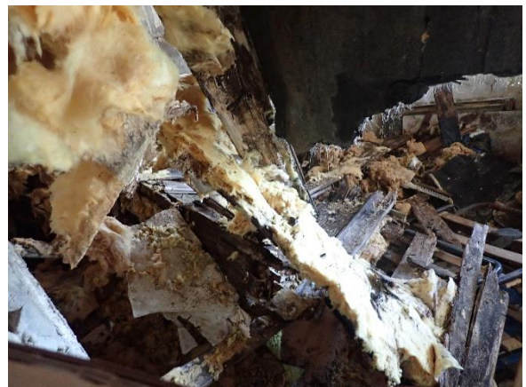
Feuchtigkeitsschaden Diele im EG (Anbau)
