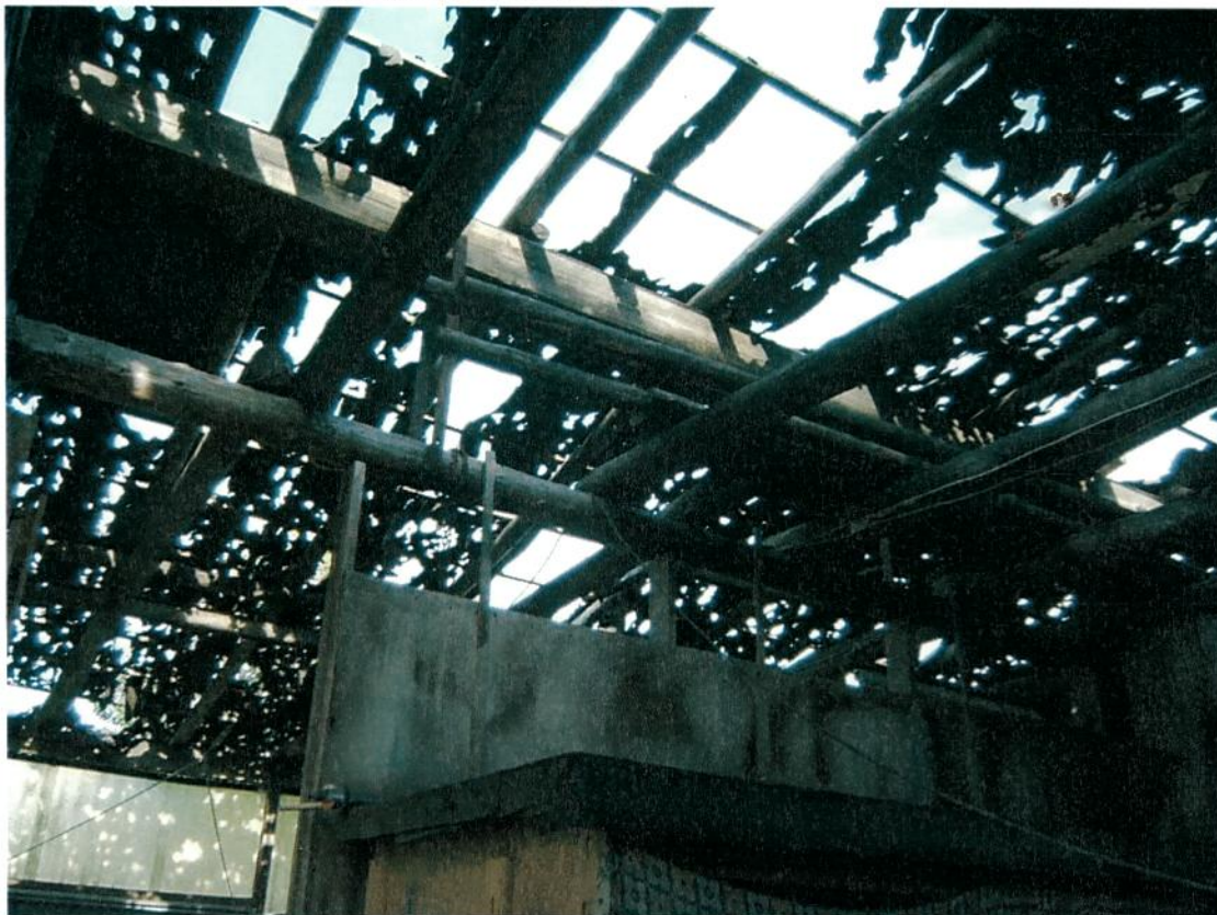
Innenansicht des Dachs der Maschinenhalle
