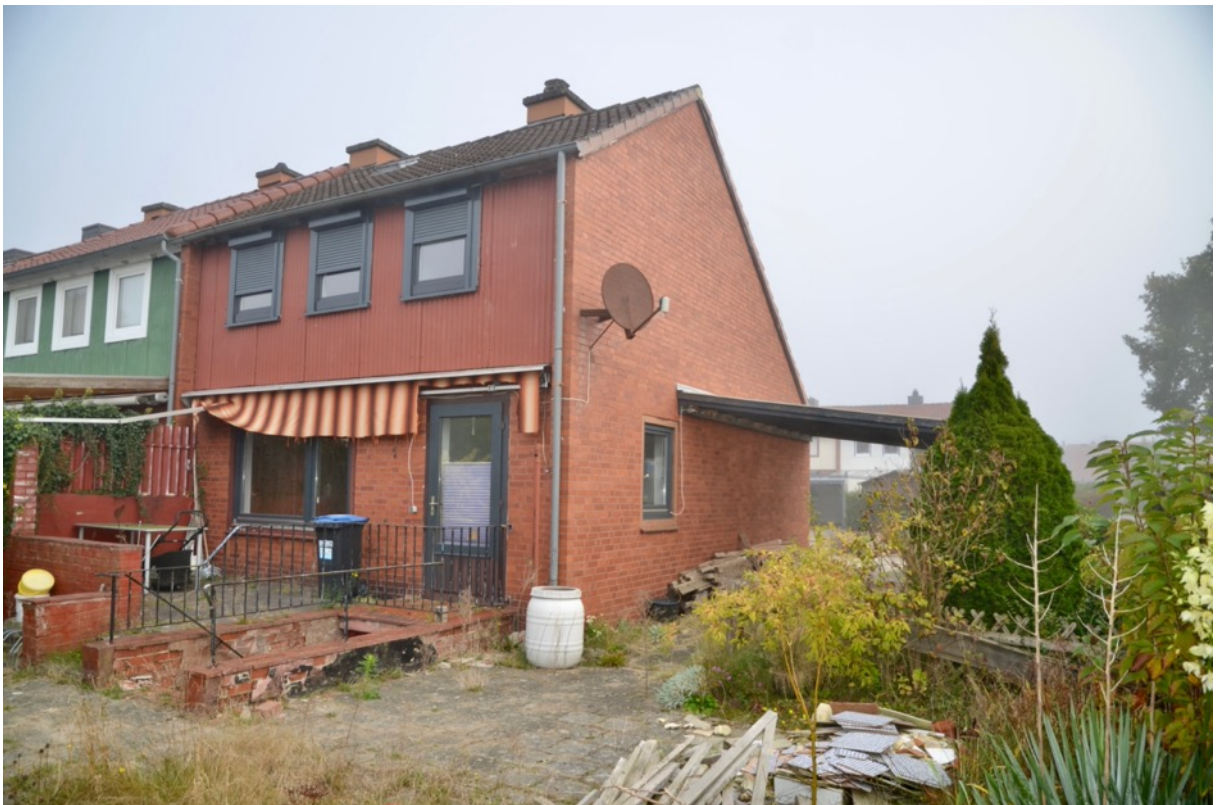
Foto 3 Südansicht Reihenendhaus Pos. 1 mit Nachbarbebauung, rechts Carport Pos. 2
