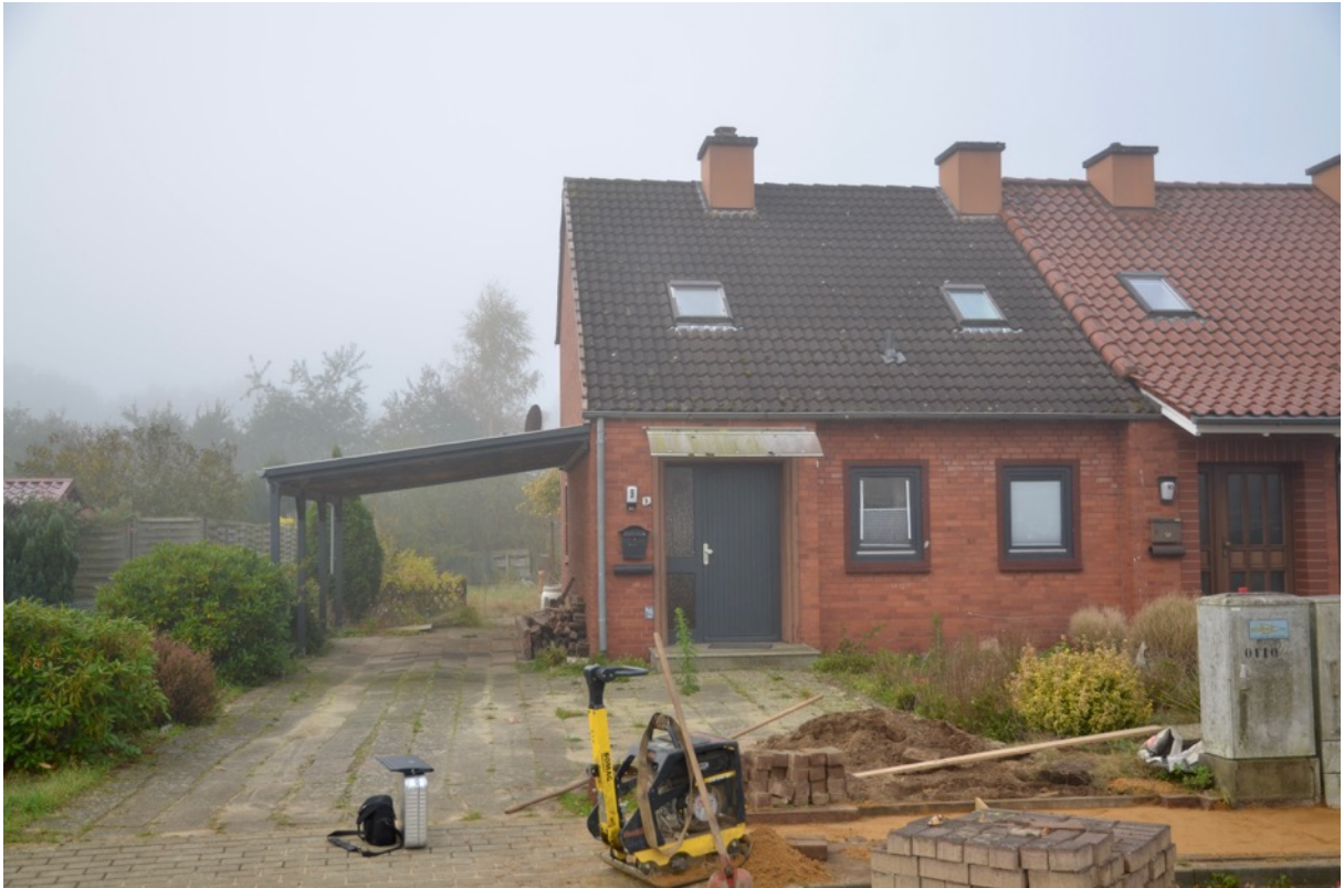
Foto 1 Straßenansicht von Nordosten Reihenhendhaus mit Nachbarbebauung, links Carport Pos. 2
