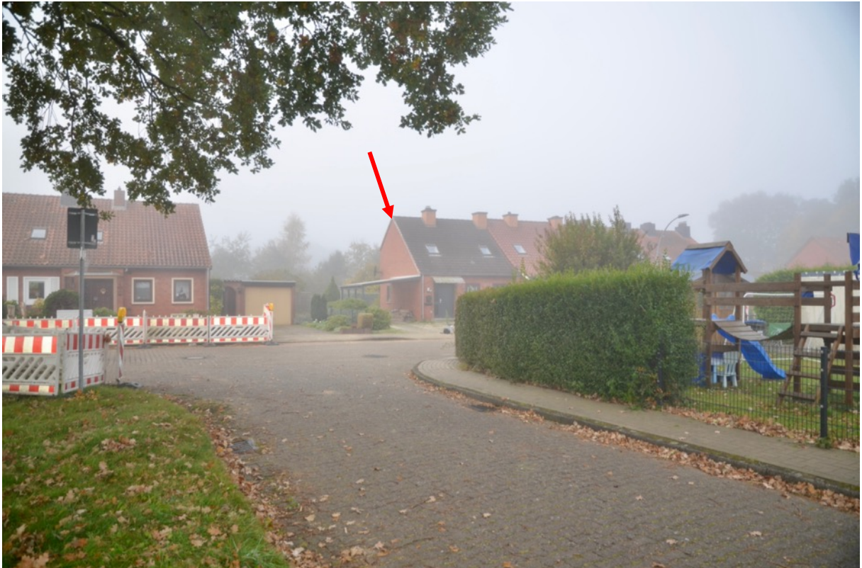
Foto 7 Danziger Ecke Königsberger Straße mit Blick Richtung Südwesten, gegenständliches Reihenendhaus nachträglich rot markiert
