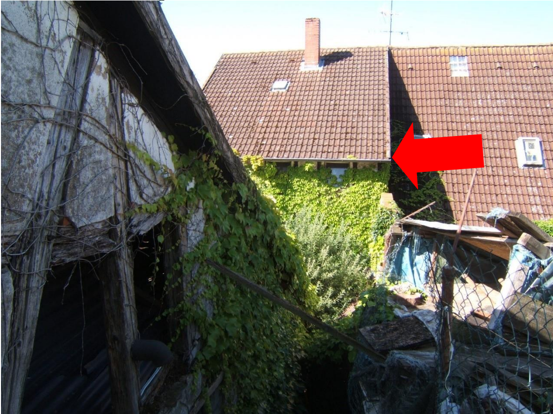
Rückansicht von der Bergstraße
