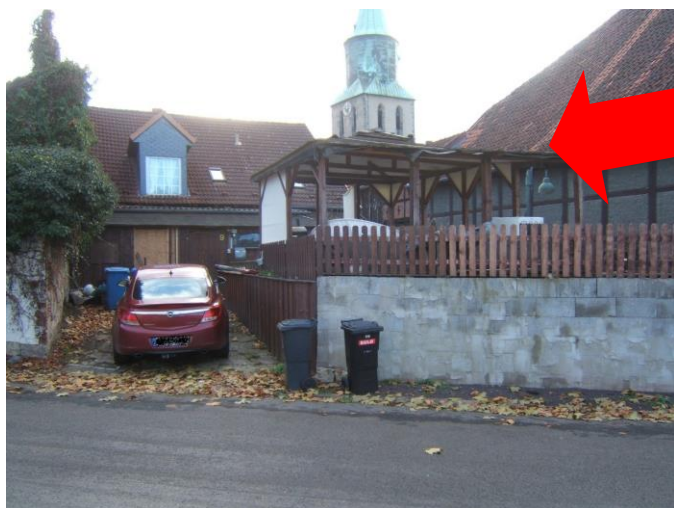
Rückansicht von der Junkernstraße
