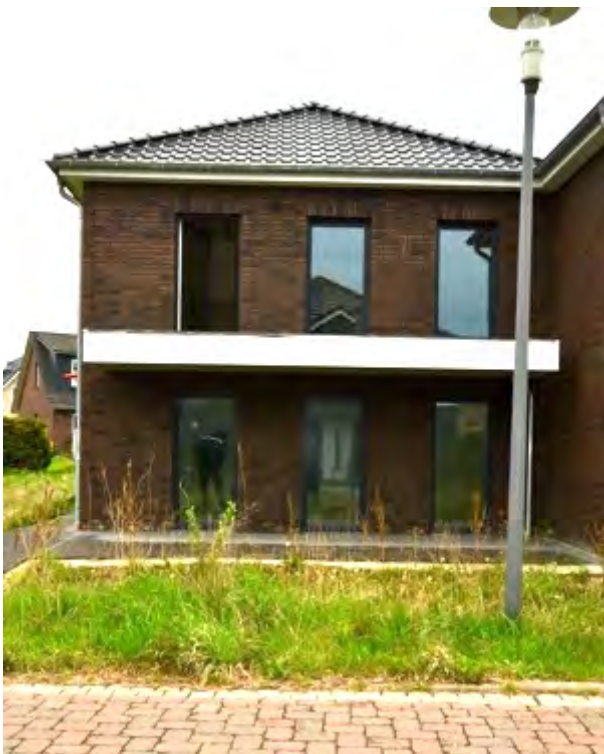
Foto 2 Straßenansicht der Doppelhaushälfte mit Anbau von Süden
