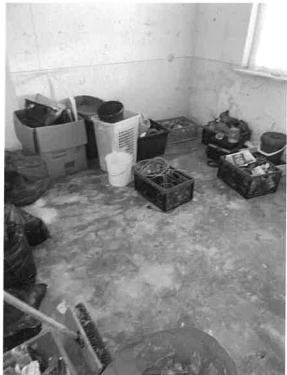
Abstellraum im Scheunentrakt
