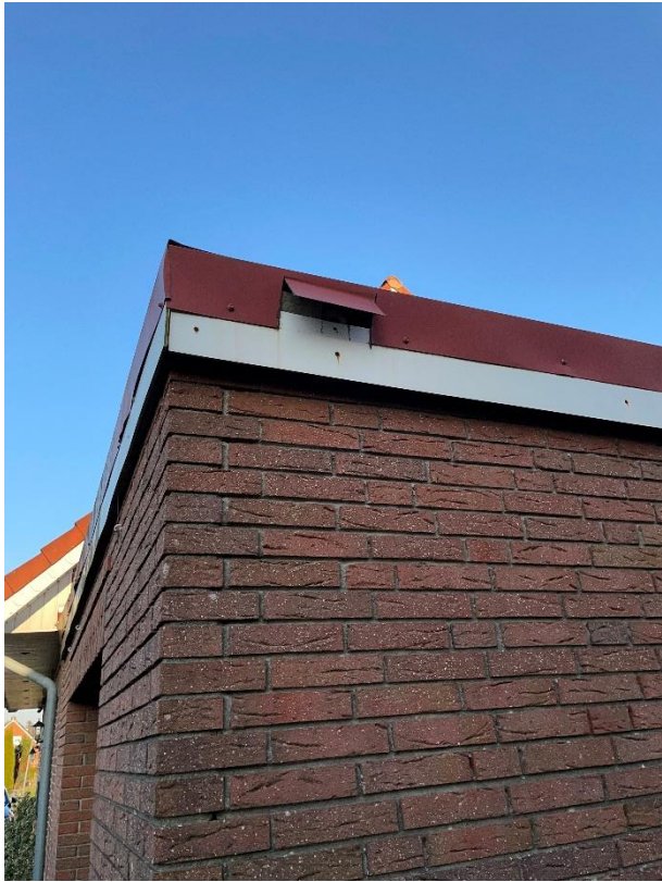
Außenmauerwerk an der Garage
