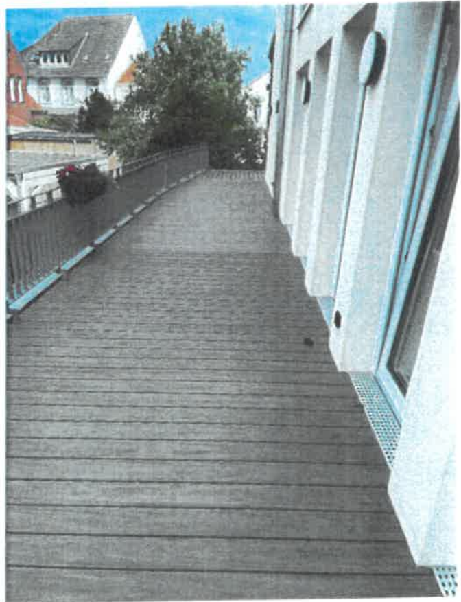
Dachterrasse am Gemeinschaftsraum
