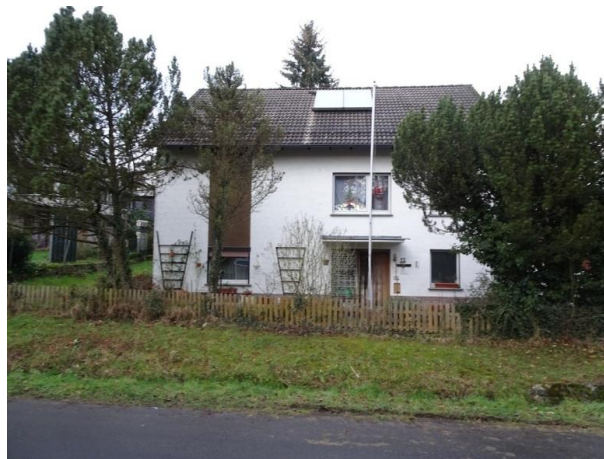
Wohnhaus – Straßenansicht - Südseite
