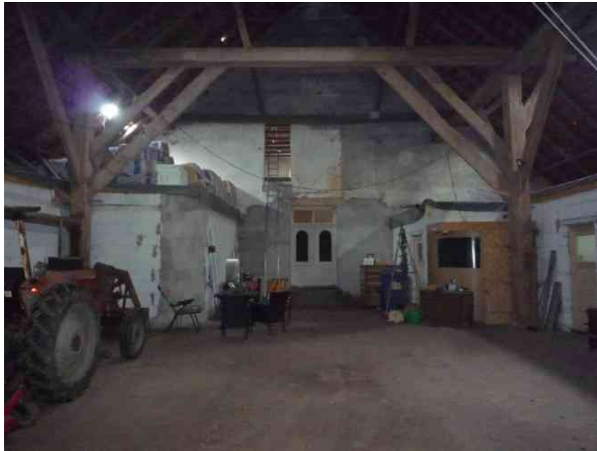
Diele im Wirtschaftsteil mit Innenausbauten und Wohnungstür
