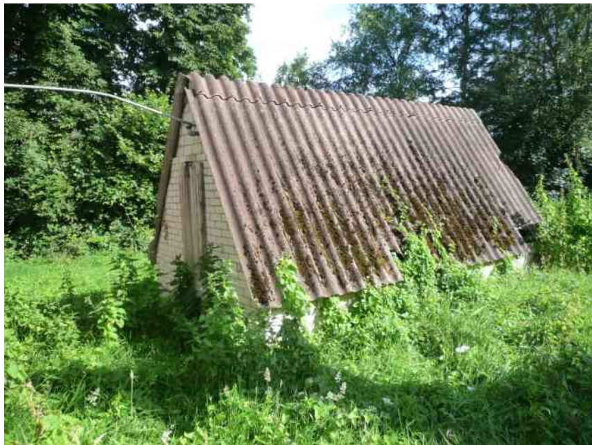
Gartenhaus hinter der Remise, Südansicht
