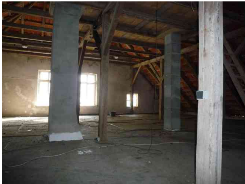
zzt. nicht ausgebautes Dachgeschoss
