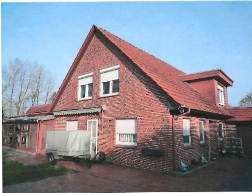
Wohnhaus mit Anbauten, Südostansicht von der Zuwegung aus
