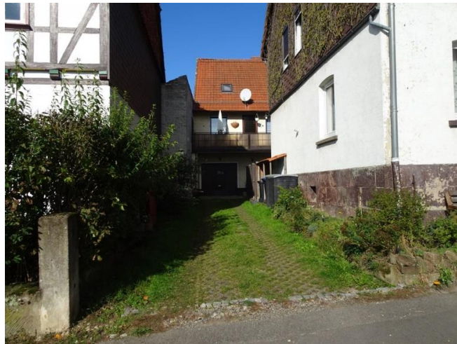
Grundstückszufahrt über das Vordergrundstück Wegerecht
