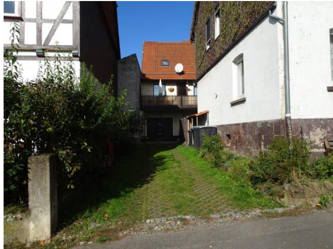
Grundstückszufahrt über das Vordergrundstück Wegerecht
