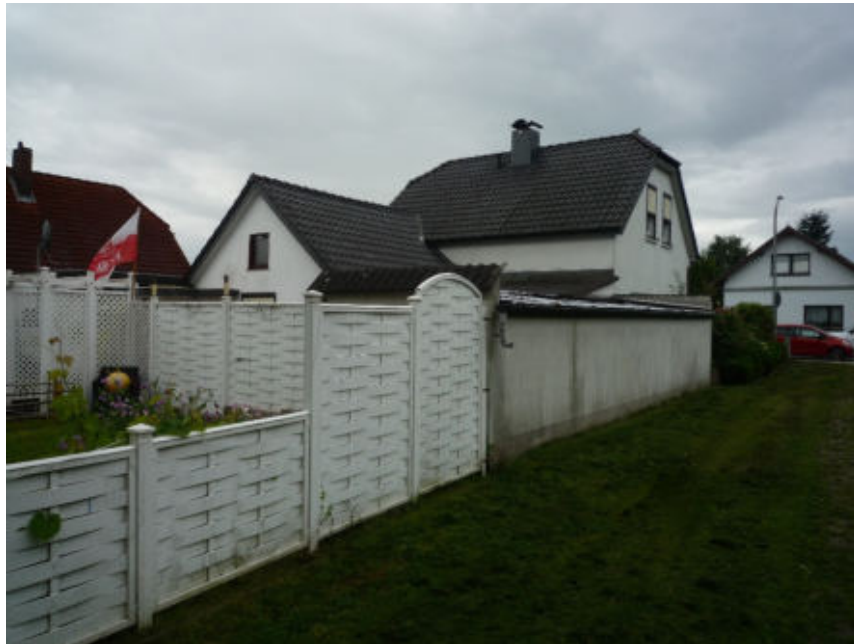
Wohnhaus mit Anbauten, Nordwestansicht
