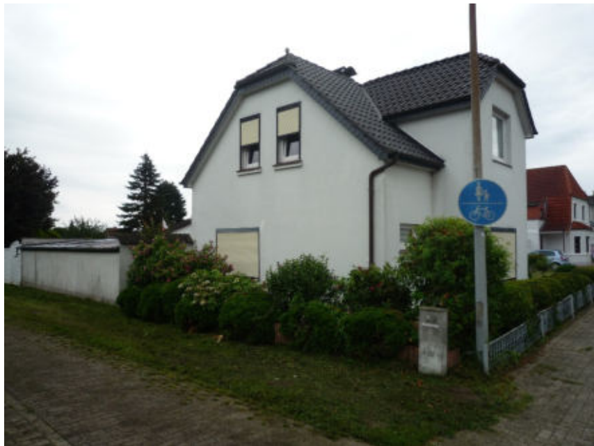
Wohnhaus mit angebautem Nebengebäude, Südwestansicht
