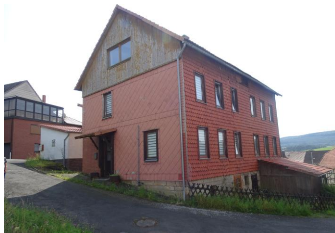
Westseite – Nordgiebel Nebengebäude
