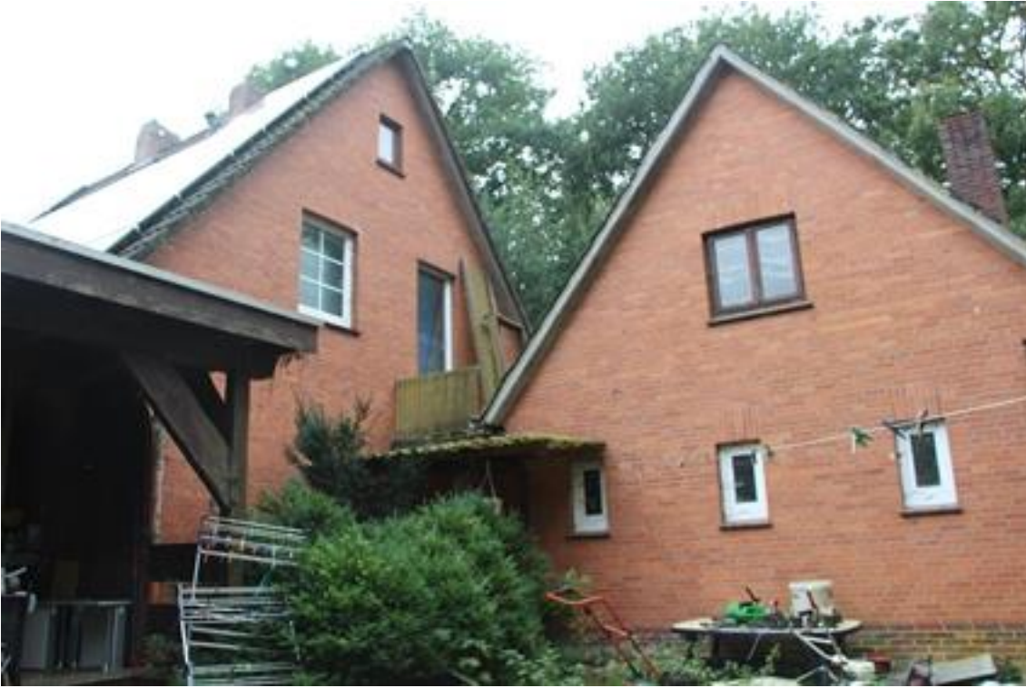
Foto 3 (Nordostansicht . Wohnhaus mit Garage / Stall)
