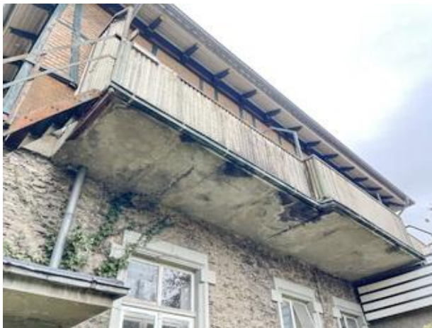
Unterseite des Balkons
