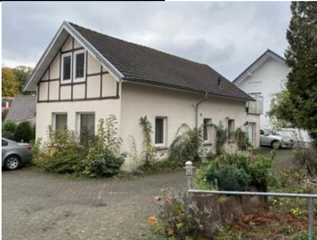
Remise über das Grundstück Parkstraße 9 zu Erreichen - Nordwestansicht
