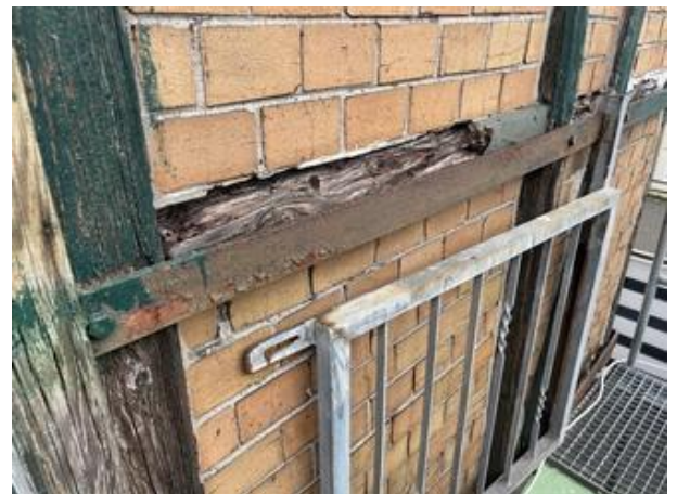
Beispielhaft für den Zustand des Fachwerks
