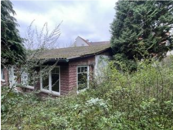
Baukörper (ehem. Stall) auf dem Grundstück Parkstraße 11
